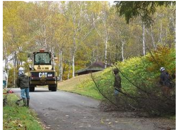
伐採した枝を回収に向かうタイヤショベル
