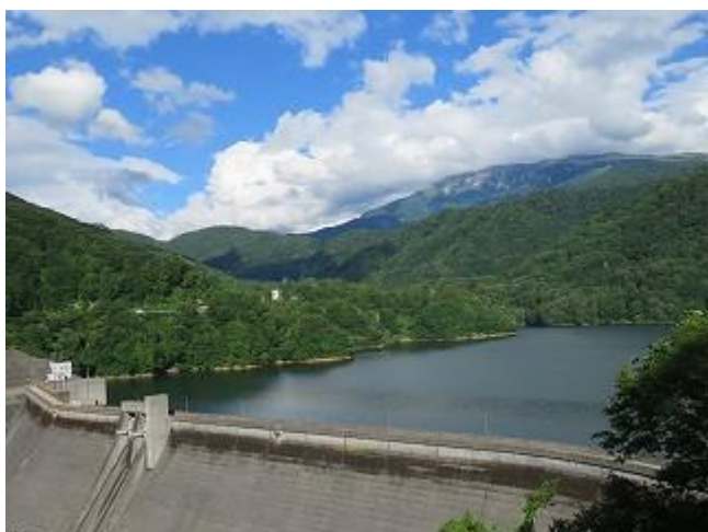
小口川線展望台より有峰ダムと薬師岳を望む （小口川線展望台より8/11撮影）
