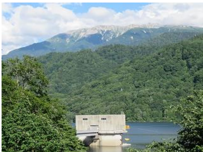
小口川線と西岸線の分岐点不動谷橋より有峰湖と薬師岳を望む（不動谷橋より8/11撮影）
