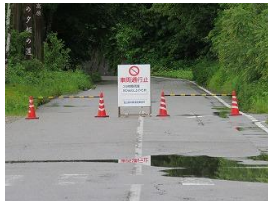
北電記念館前の小見線に設置された車両通行止めの看板とゲート（7/8撮影）
