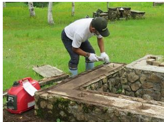
サンダーで腐食したボルト切断中の指導員 (6/27 撮影)
