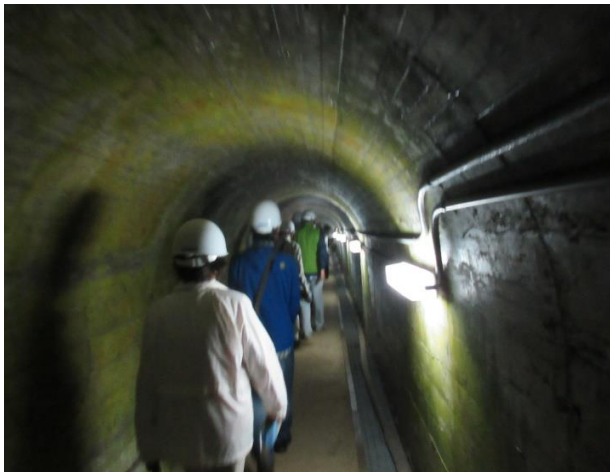
③(28日13:38) 有峰ダム堰堤内通路の歩行
